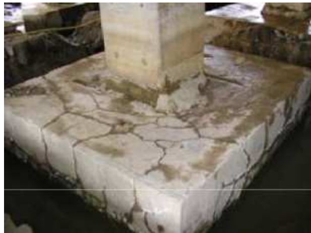
Figura 47 - Exemplo de estrutura com ocorrência de RAA
