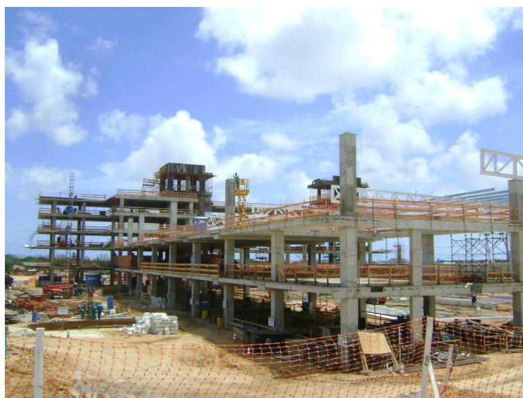
Figura 24 - Estrutura de concreto
