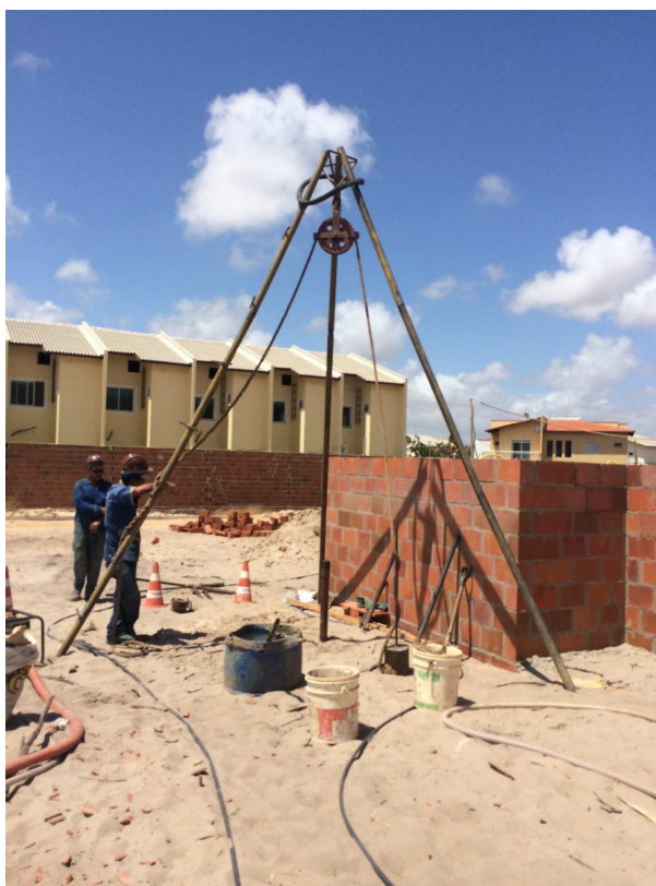
Figura 12 - Sondagem à percussão
