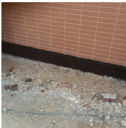
Figura 34 - Aplicação de Camada Impermeabilizante
