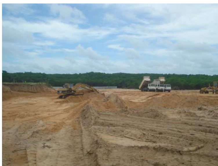
Figura 18 - Movimentação de terra em uma obra pública
