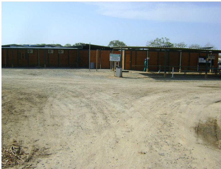
Figura 13 - Exemplo de Canteiro de Obras
