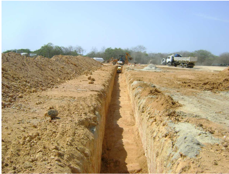
Figura 20 - Método Drenagem em Valas
