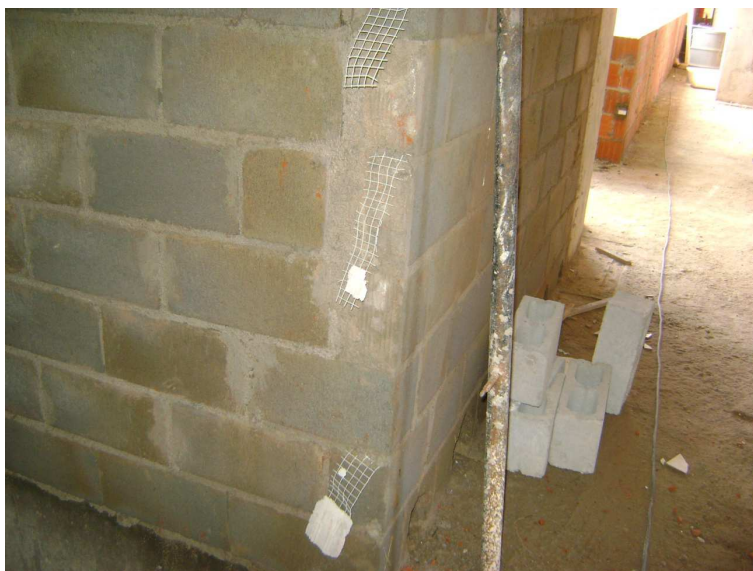
Figura 26 - Bloco de Concreto
