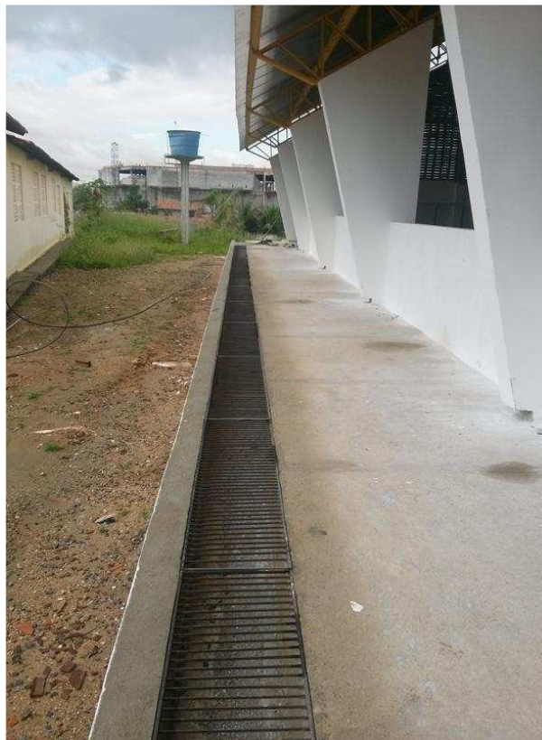
Figura 22 - Drenagem Superficial
