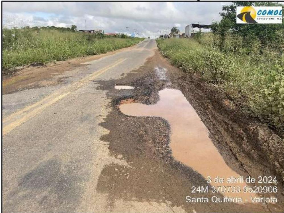
Foto 4 – Interseções sem revestimento
