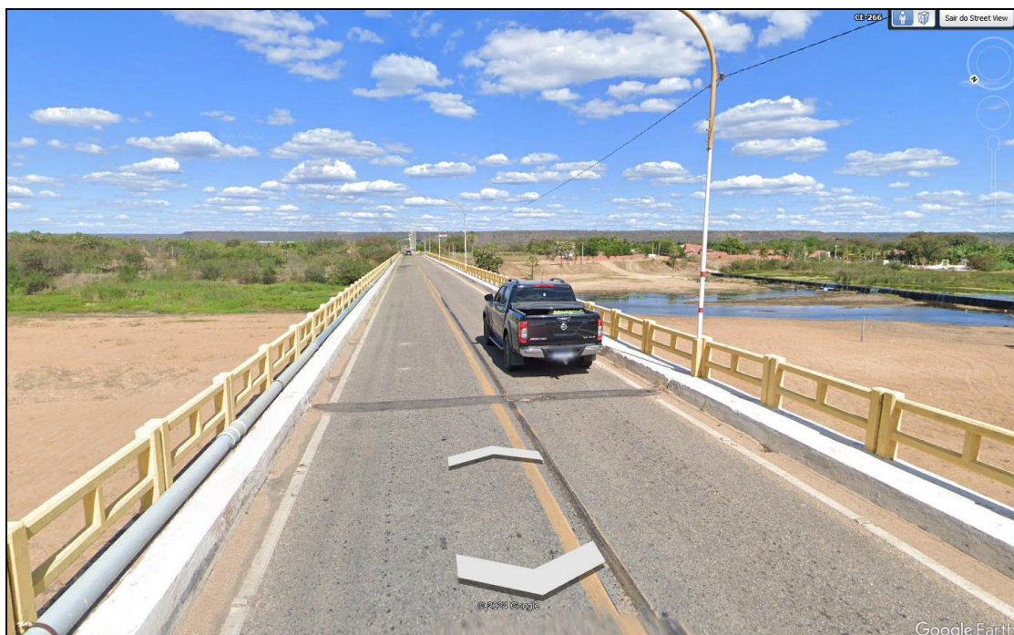
Foto 2 – Ponte sobre um braço do Rio Jaguaribe
