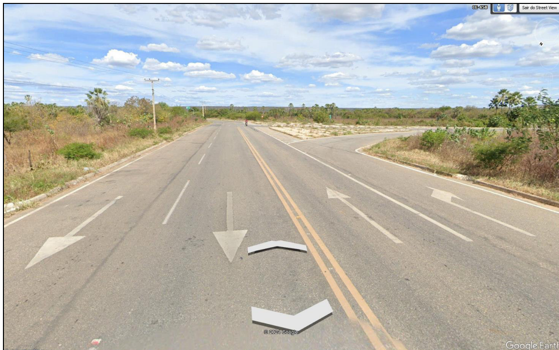
Foto 3 – Fim do Trecho (entroncamento com a CE-458 - Quixeré)
