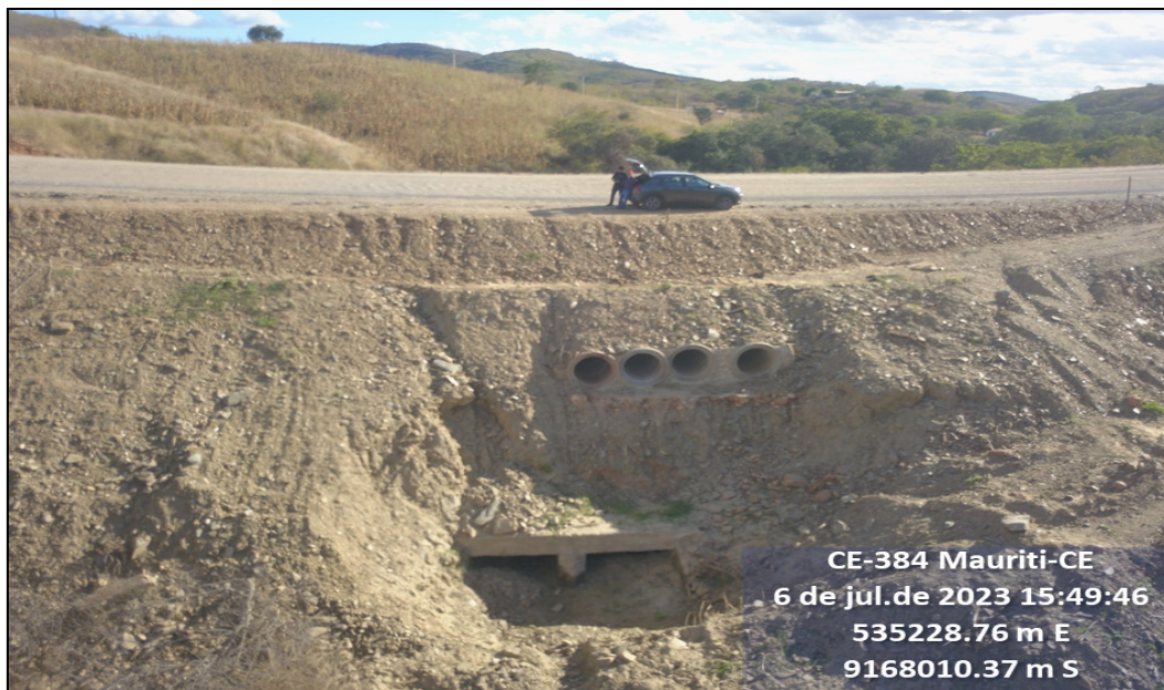
Foto 3 – Bueiros a serem substituídos - bueiros com manilhas de concreto e do corpo estradal com revestimento primário. Estaca - 965
