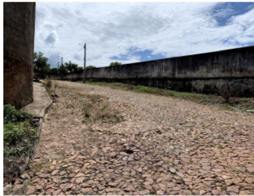
Foto 7 - Leito existente / Fim de do trecho (Abaiara)
