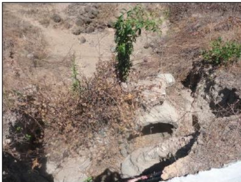
Foto 3 – Situação modelo de bueiro danificado
