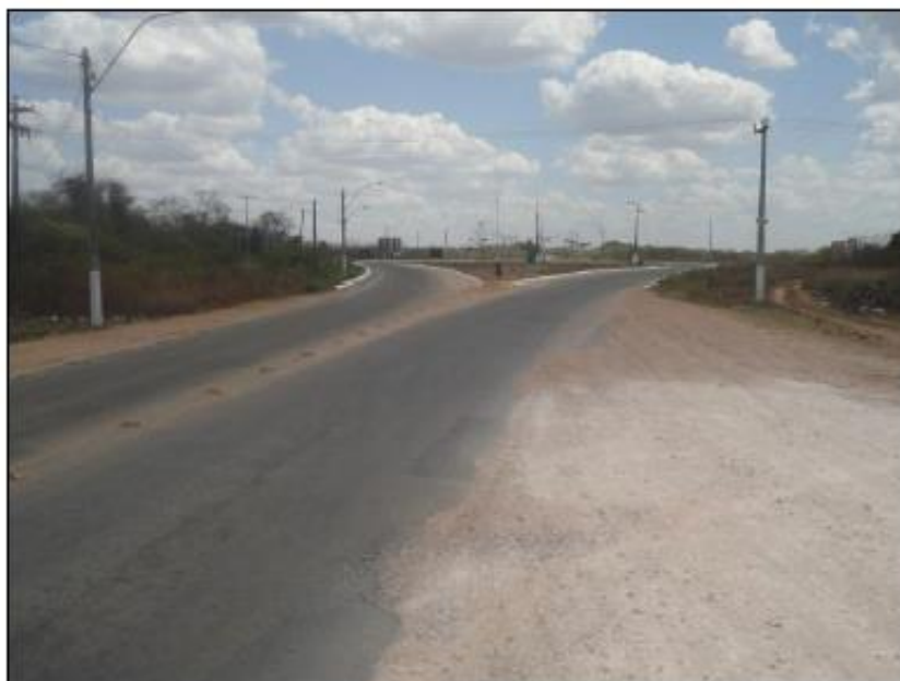
Foto 2 – Situação modelo de acostamento danificado
