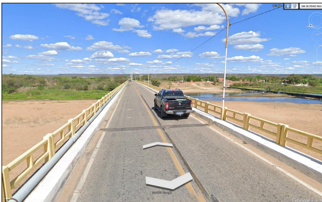
Foto 2 – Ponte sobre um braço do Rio Jaguaribe
