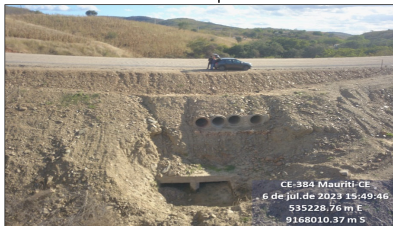
Foto 2 – Bueiros a serem substituídos - bueiros com manilhas de concreto e do corpo estradal com revestimento primário. Estaca – 865
