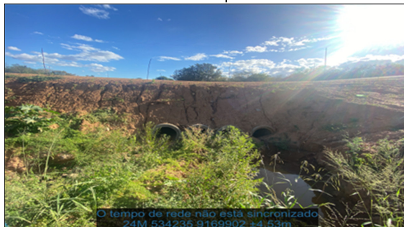
Foto 3 – Bueiros a serem substituídos - bueiros com manilhas de concreto e do corpo estradal com revestimento primário. Estaca - 965
